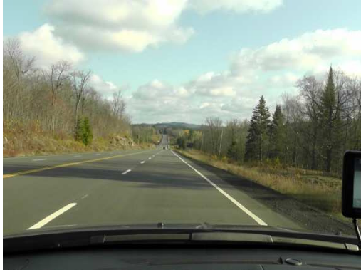
Highway 60 durch den Park
